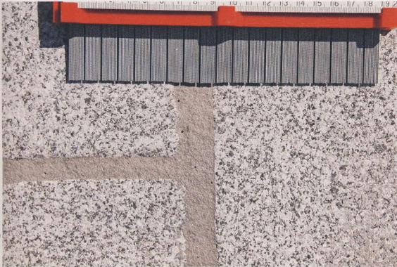
**Abbildung 5:** Die Fugenvertiefung beträgt minimal < 1 mm.
